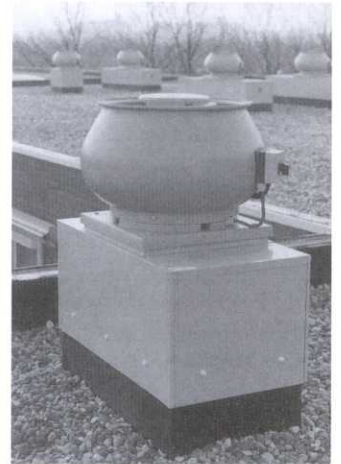
Montage plenum type MK en dakventilator type CAS.
